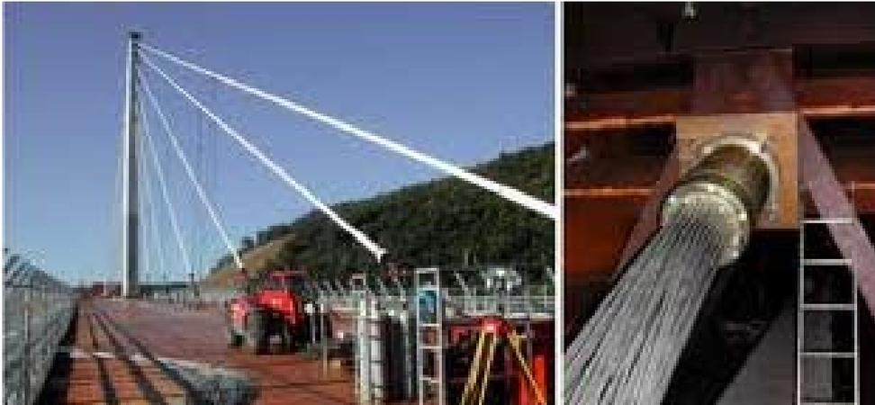
Un hauban peut mesurer tendu jusqu'à 180m et pèse jusqu'à 25 tonnes.
